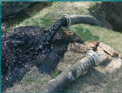
Austritt von gelösten Inkrustierungen und Spülwasser aus der Ableitung in eine Zwischenlagerung.
