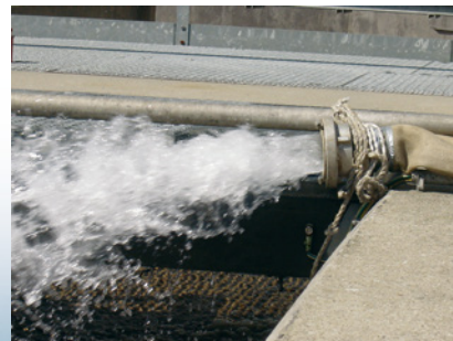
Austritt von klarem Brunnenwasser nach dem letzten hydromechanischen Reinigungsgang.
