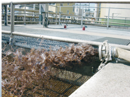
Austritt gelöster Mangan-Ablagerungen in der Kläranlage.
